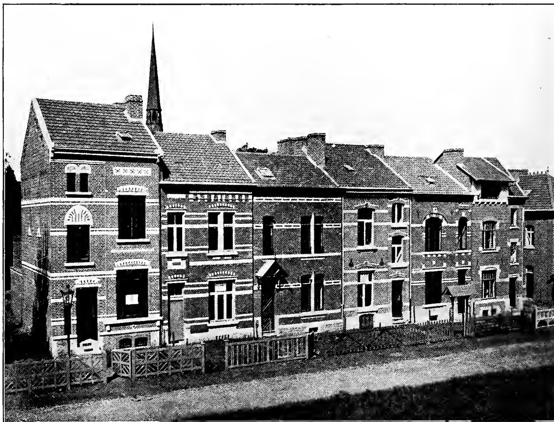
MAISONS OUVRIÈRES DE COINTE. — GROUPE CENTRAL. —
